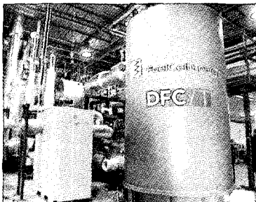
그림 12 FuelCell energy 사의 DFC/T hybrid system
