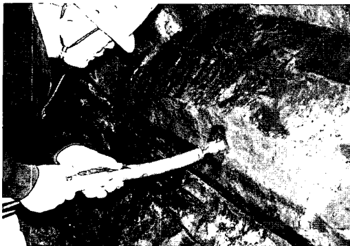
그림 17. 장약공에 시험 장비 설치모습
