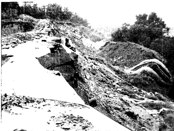
그림 1. 붕괴된 보강토 옹벽의 주변상황 사진
