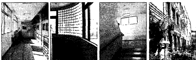
<사진 24-27> 사나다야마 소학교 복도 양측창, 복도 유리블록, 계단, 벽면녹화
