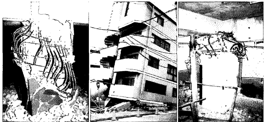
a. 기둥의 전단파괴에 의한 붕괴 b. 1층에 과도한 변형집중에 의한 층붕괴 c. 전도모멘트에 의해 커다란 변동축력이 기둥에 작용에 의한 붕괴 사진 4. 필로티 건축물의 붕괴형식의 분류
