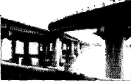
- 교량 상부 구조 및 하부구조
