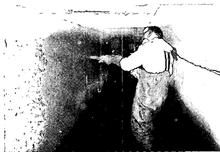
사진 5. 스프레이를 통한 시공 전경
