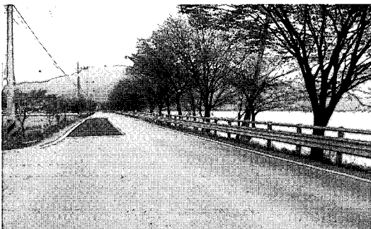
그림 2. 접근도로 및 안전시설
