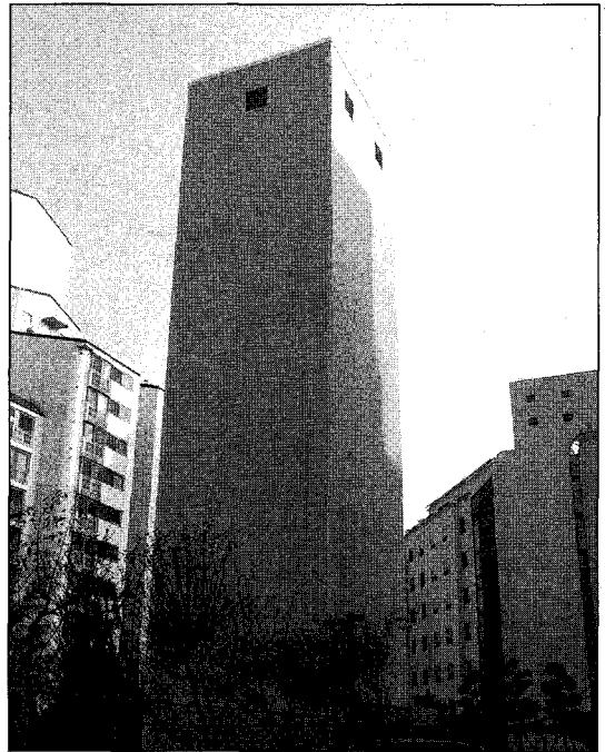
회의가 많은 협회이기 때문에 많은 주차장을 확보해야 했다. 따라서 주차타워를 설치하여 주차문제를 해소하였다.
