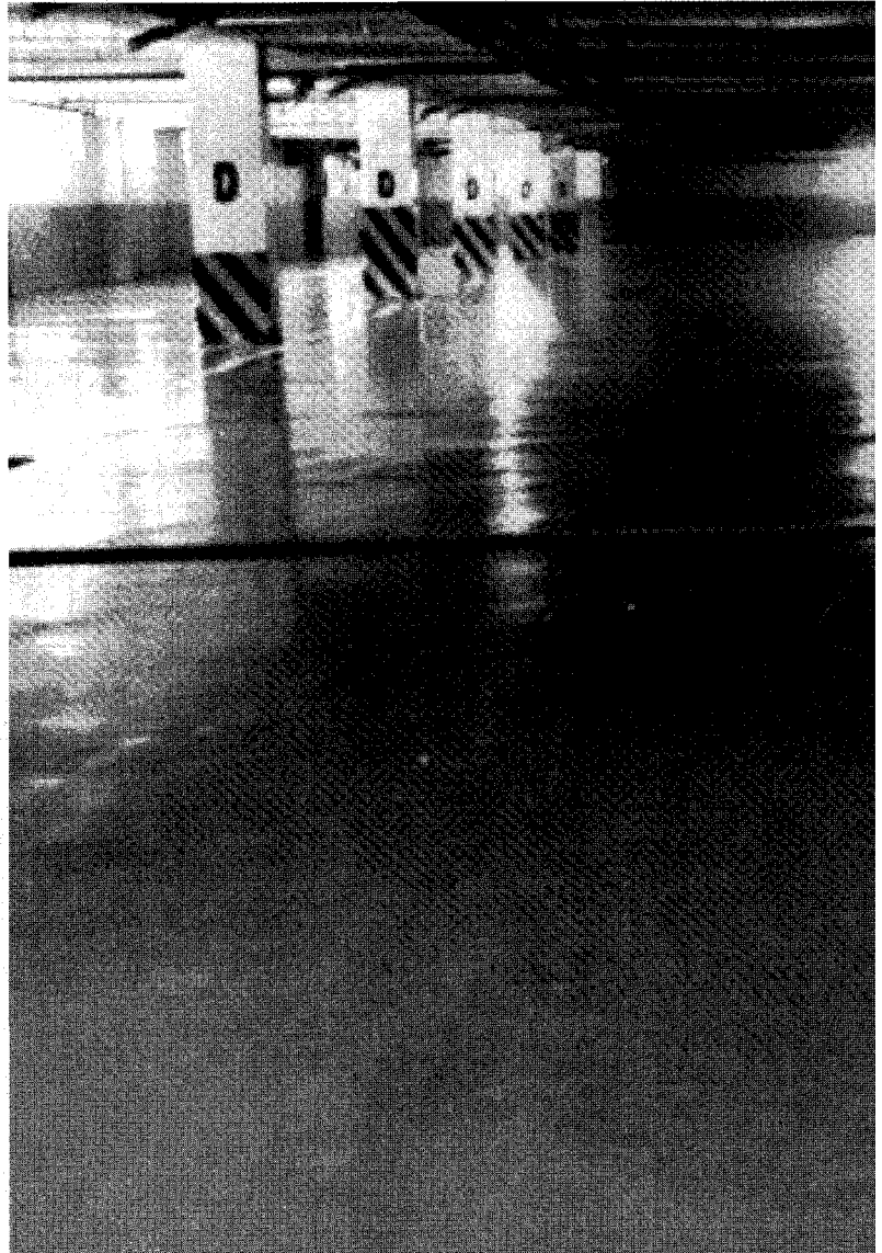
(주)국제특수건설에서 시공한 지하주차장
