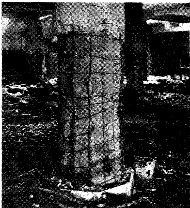
<사진 1> 화재에 의한 콘크리트 구조물의 피해 (1)
