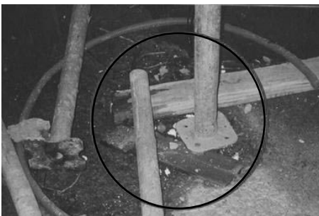
〈사진4〉 경사 램프부분 동바리 상태
