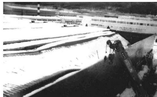
〈사진1〉 붕괴사고부위를 크레인으로 정리하고 있는 모습
