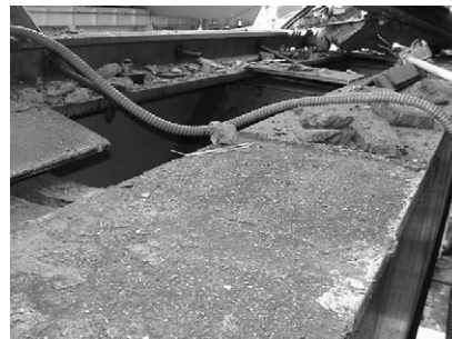
<사진1> MT2+CRANE 주행보 접합부(용접부분)
