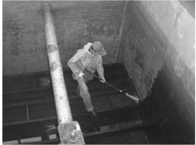
그림 7) 전염소 투입으로 인한 여과지등 내부 부식 및 시설물 망간산화물 침착
