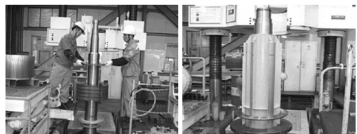
Rotor Shaft 설치 작업
