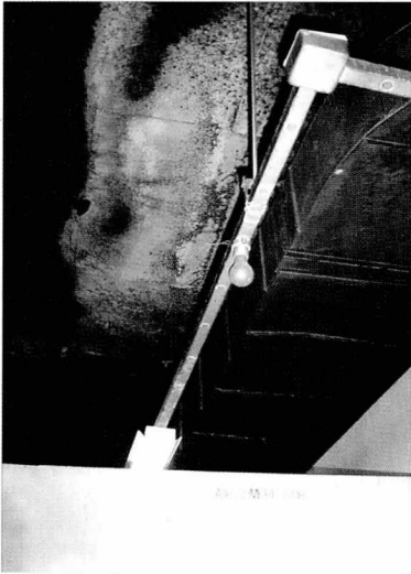
▲ MOF 수납함 안에 MOF 등이 소손되어 떨어져 있는 모습 ◀ 고열(600°C 이상)에 의해 검은 그을음이 완전 연소되어 하얗게 된 MOF 바로 위 천장 부분
