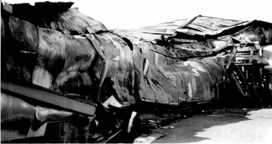
[사진 3] 화재건물 단층부 외벽과 지붕이 내려앉은 모습
