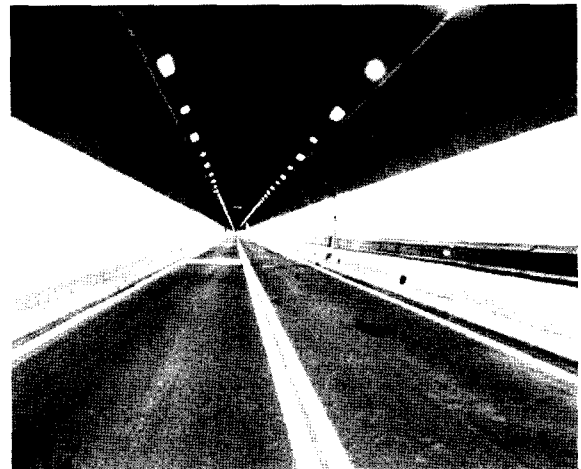
그림 20. 노르웨이 Laerdal 터널의 조명
