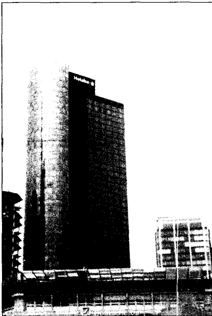
사진 1. 대형 지중열 말뚝을 활용한 세계 최초의 고층빌딩 (Main Tower in Frankfurt)
