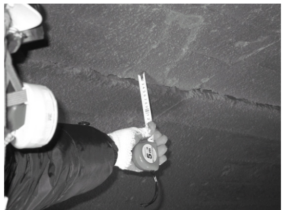
그림 3. 변상이 발견된 지점에서의 종방향 단차균열
