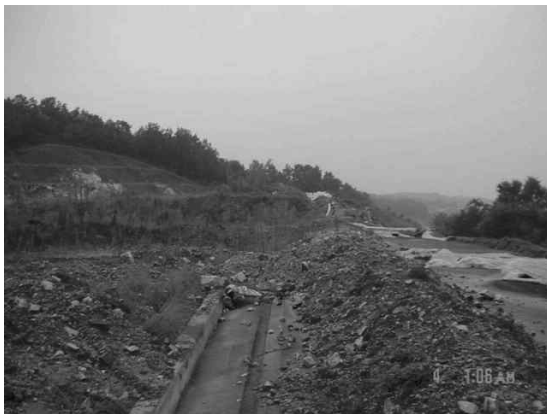
그림 4. 공장부지 조성 및 부대 토목시설물
