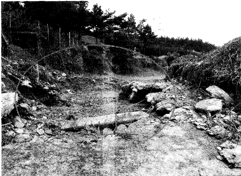
그림 3. 폭파에 의해 여수로 바닥고를 낮춘 장면
