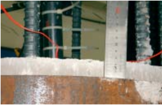
Photo 3 내부 속채움 콘크리트 뱀힘
