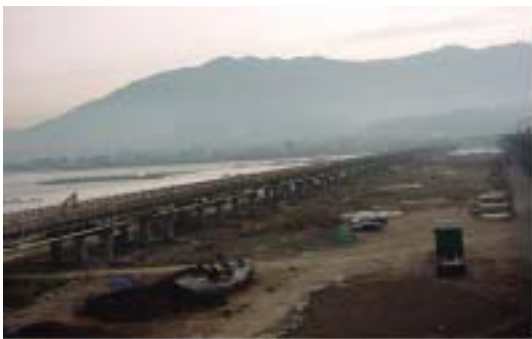
Fig. 4 다경간 연속 게르버 판형교인 xx교의 주형 및 측면 전경
