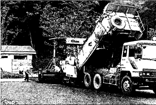
사진 1. 모체 아스팔트 혼합물의 포설
