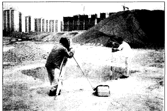
그림 10. 토탈스테이션을 이용한 지형측량
