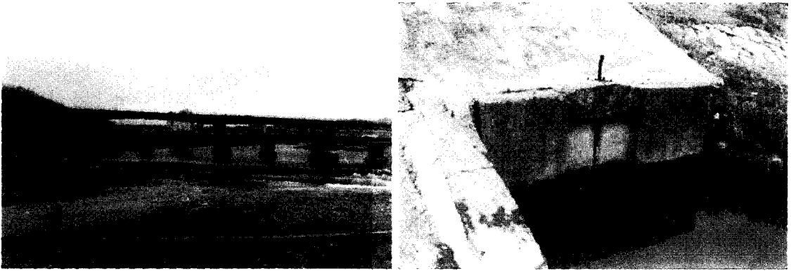
그림 13. 곡릉천 송강보의 노후화된 모습(좌)과 고장난 취수문 현황(우)
