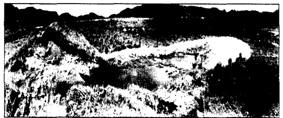
그림 3. 월류에 의한 제방붕괴(경남 함안 광려천 구포제, 2003년 태풍 매미)
