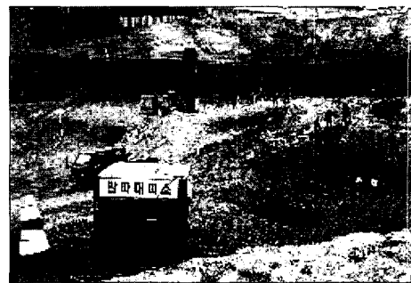
그림 9. 발파대피소 설치 운용
