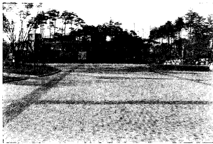
(b) 광촉매 벽돌의 시공현장(상암월드컵 경기장)
