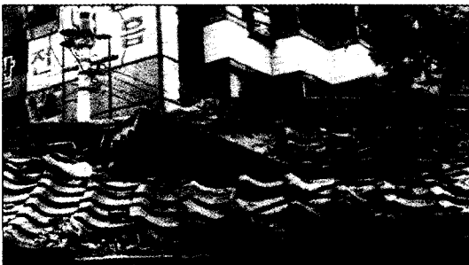
지붕에 박힌 지하철 공사장의 복공판(1995. 4., 대구) : 폭굉으로 천이된 가스폭발의 위력이 얼마나 큰지는 공사장의 철제 복공판의 비산된 위치로 짐작할 수 있다.
