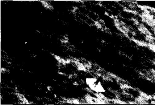
그림 9. 지압판 설치
