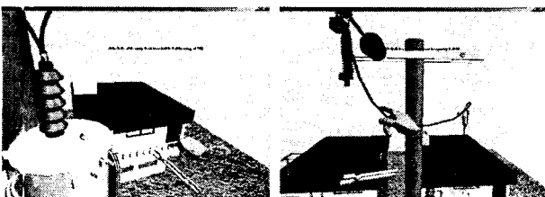
그림 4.13 2차 클램프 철거 후 1차 클램프 철거 Fig. 4.13 Removing 2nd and 1st Clamp
