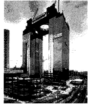
〈그림 4〉 공중정원 Lift-Up 시공 모습
