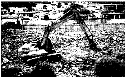
[그림 4.1] 현행 해체방법에 의한 현장에서의 콘크리트 잔재의 발생형태
