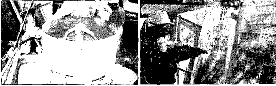
a. 비빔 전경 b. spray 형의 타설 전경 사진 8. Hybrid-Spray-DFRCC의 비빔 및 타설 전경
