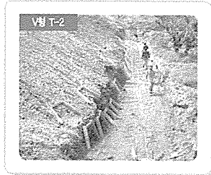
⑦ 되메우기 작업
