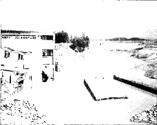
그림 2. 2000년 9월 16일 태풍 사오마이에 의한 봉산제방 붕괴 현장 (봉산제방 및 포동배수장, 배수문암거 구조물 붕괴 모습)
