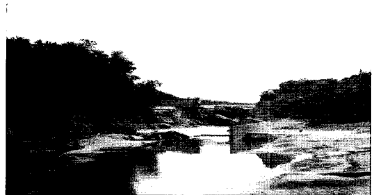
그림 1. 장현저수지 제체유실 및 붕괴된 전경
