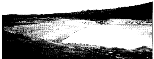
그림 2. 동막저수지 제체유실 및 사면 슬라이딩 발생 전경
