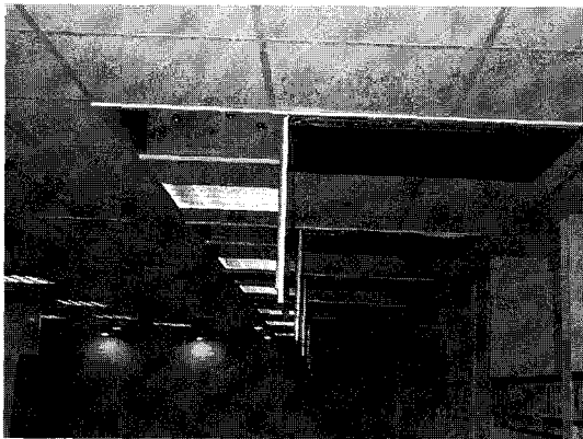
사진 5. COIL 내장형 FFU
