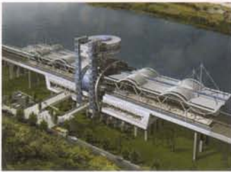
〈표지사진〉 경춘선 백양리 역사 (T/K 도화구조/백림건축/LG건설)
