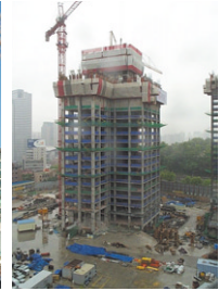
(그림 12) 기존층 골조 공사
