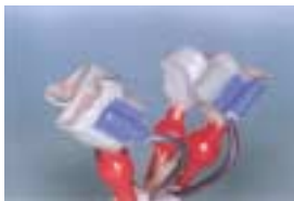
〈그림 34〉 주입선 설치
