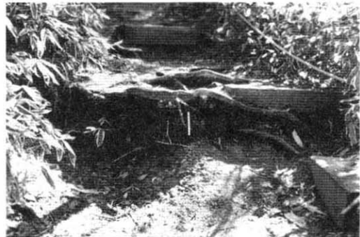
사진 5. 근계에 포획된 경사구간 등산로의 토층
