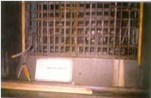
Fig. 6 콘크리트 타설 전의 Delay Joint 벽체 및 슬래브 시공이음부에 설치된 다발관
