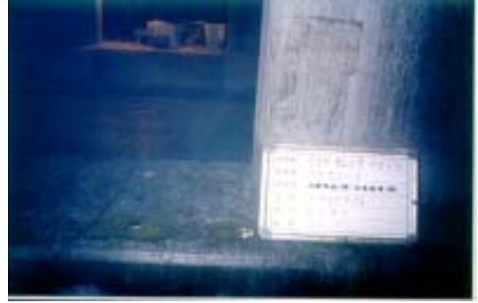
Fig. 14 다발관 그라우팅 이후 누수가 멈춘 상태
