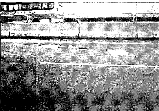
그림 17. 콘크리트포장의 응급보수
