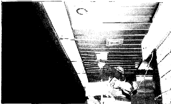
[그림 4] 리모델링전 승강장 덕트기구 배열사진
