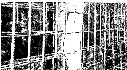
사진 4. 균열유발줄눈 설치
