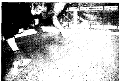
사진 3. 유황 콘크리트 마감장면
