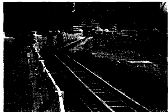
(1) 안내벽(guide wall) 설치
