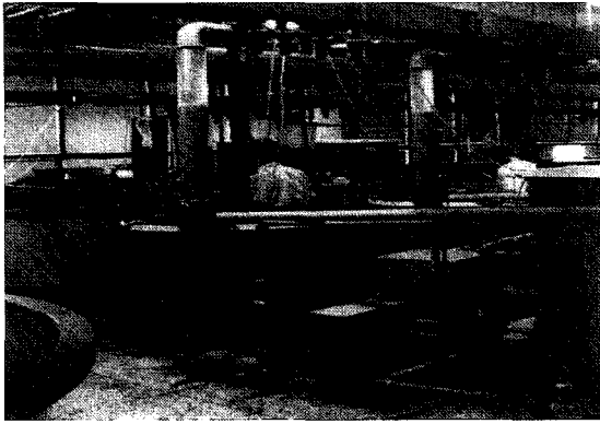
그림 3. 유동층 순환 여과 사육시스템 설치 사진
